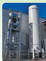
A DuoCondex berendezéshez a Messer tartályban biztosítja a cseppfolyós nitrogént.
