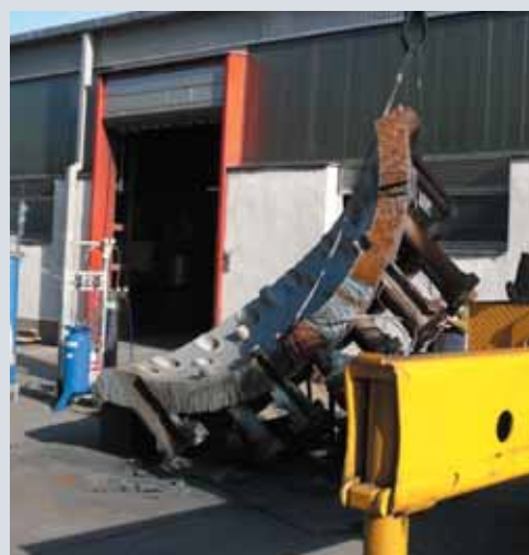
A félbevágott, közel 250 mm vastag reaktorfedél-darab
