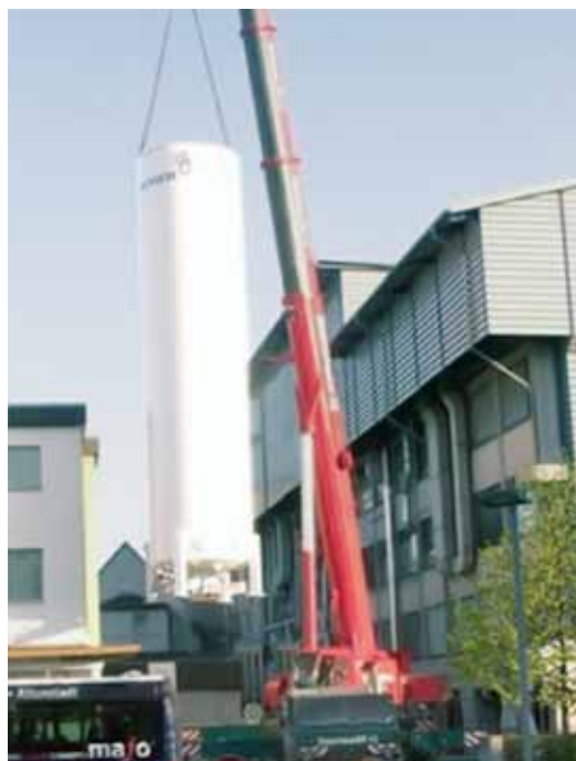
A nitrogéntartály telepítése a Zeiss üzemenél.
