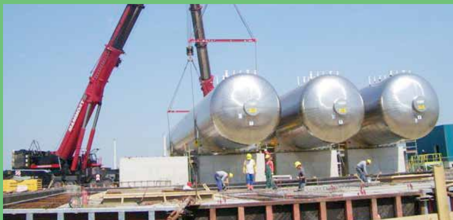
Telepítik a cseppfolyós szén-dioxid tároló tartályokat.
