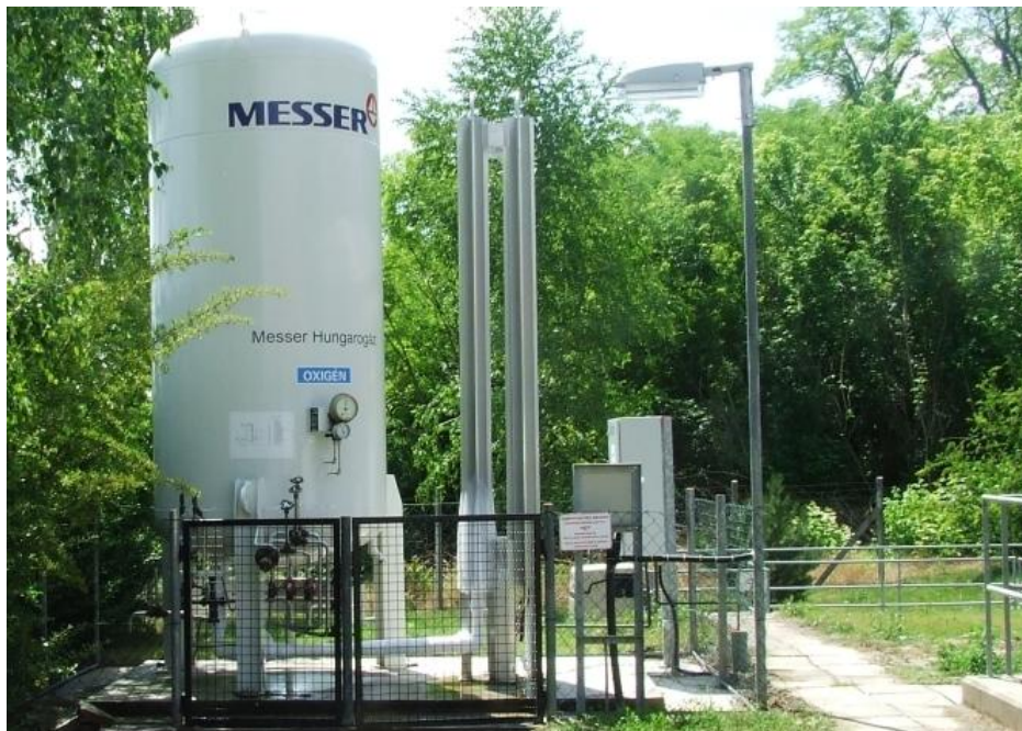
Cseppfolyós oxigén tárolótartály elpárologtatóval a mezőszilasi szennyvíztisztító telepen
