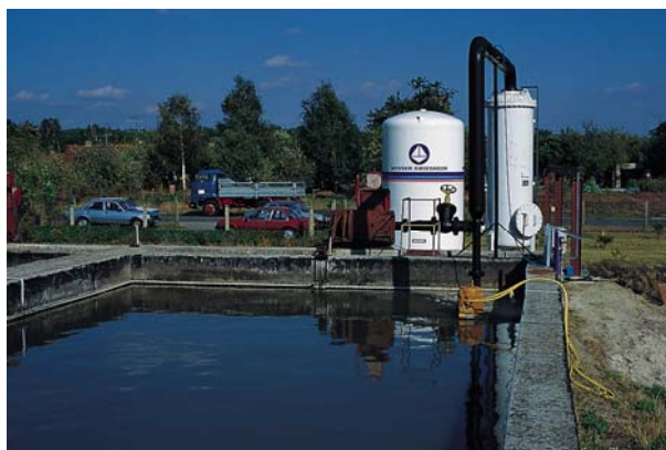
6. ábra: Az oxidátor megakadályozza a szagkibocsátást
