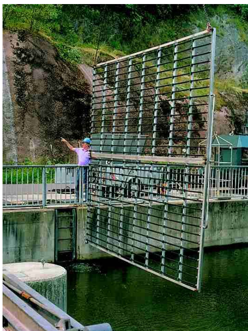
4. ábra: Oxigénmatrac szerelése feltöltött levegőztetőmedencébe
