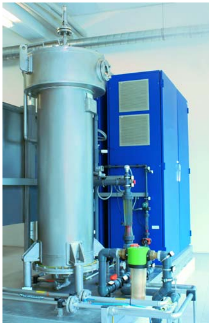
3. ábra: A modern ózongenerátorok tiszta oxigént használnak tápgázként
