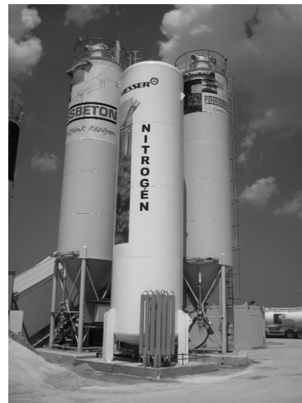
1. ábra Betongyári installáció
