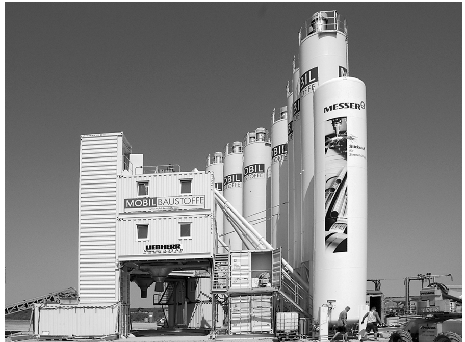
3. ábra Cementhűtő berendezés egy nagy építkezésen Bécs mellett
