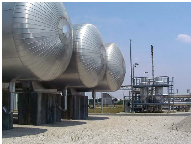
A Messer MOL Gáz ölbői szén-dioxid előállító üzemének cseppfolyós CO 2 -tárolói
