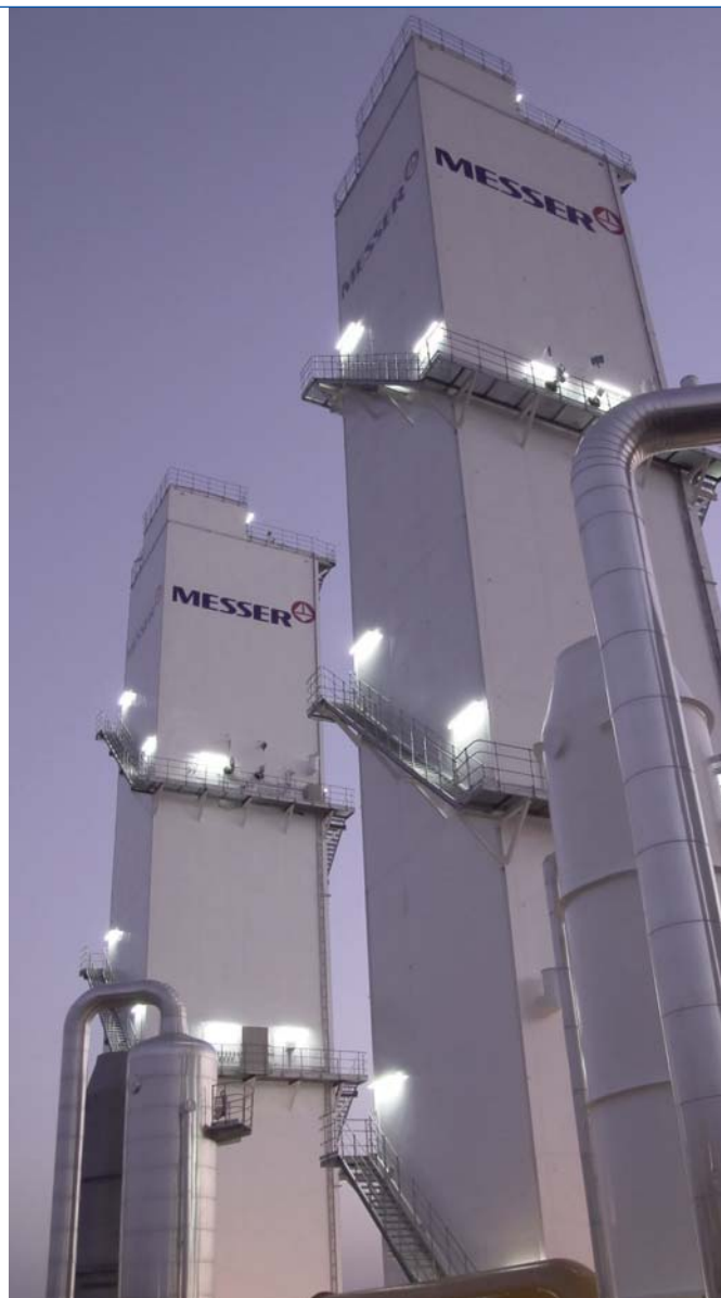
2.1 ábra Rektifikáló oszlop részlete
