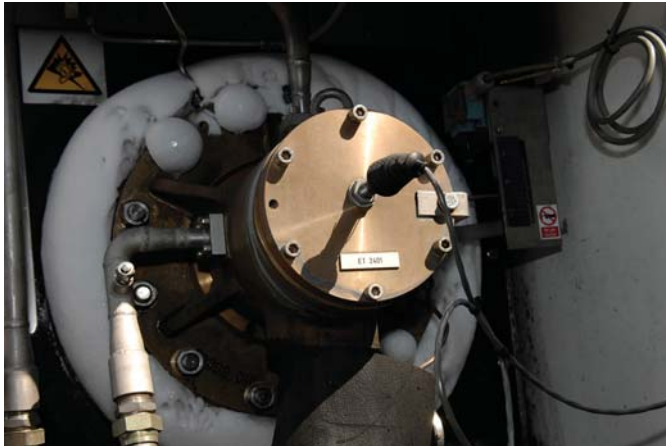
Expanziós turbina
