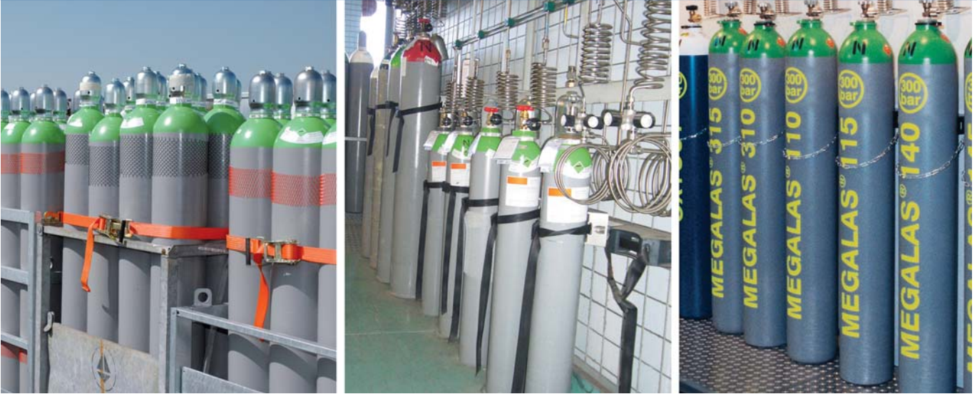
Palettában, valamint falhoz hevederrel és láncsal helyesen rögzített palackok
