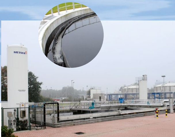
A lúgos kémhatású szennyvizek semlegesítése a képen látható biológiai szennyvíztisztító telephez hasonlóan számos iparágban szükséges.
