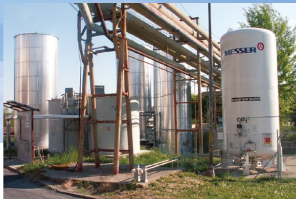
A szén-dioxidos szennyvíz semlegesítés jól alkalmazható kisebb üzemeknél is, mint például a képen látható tejüzem.
