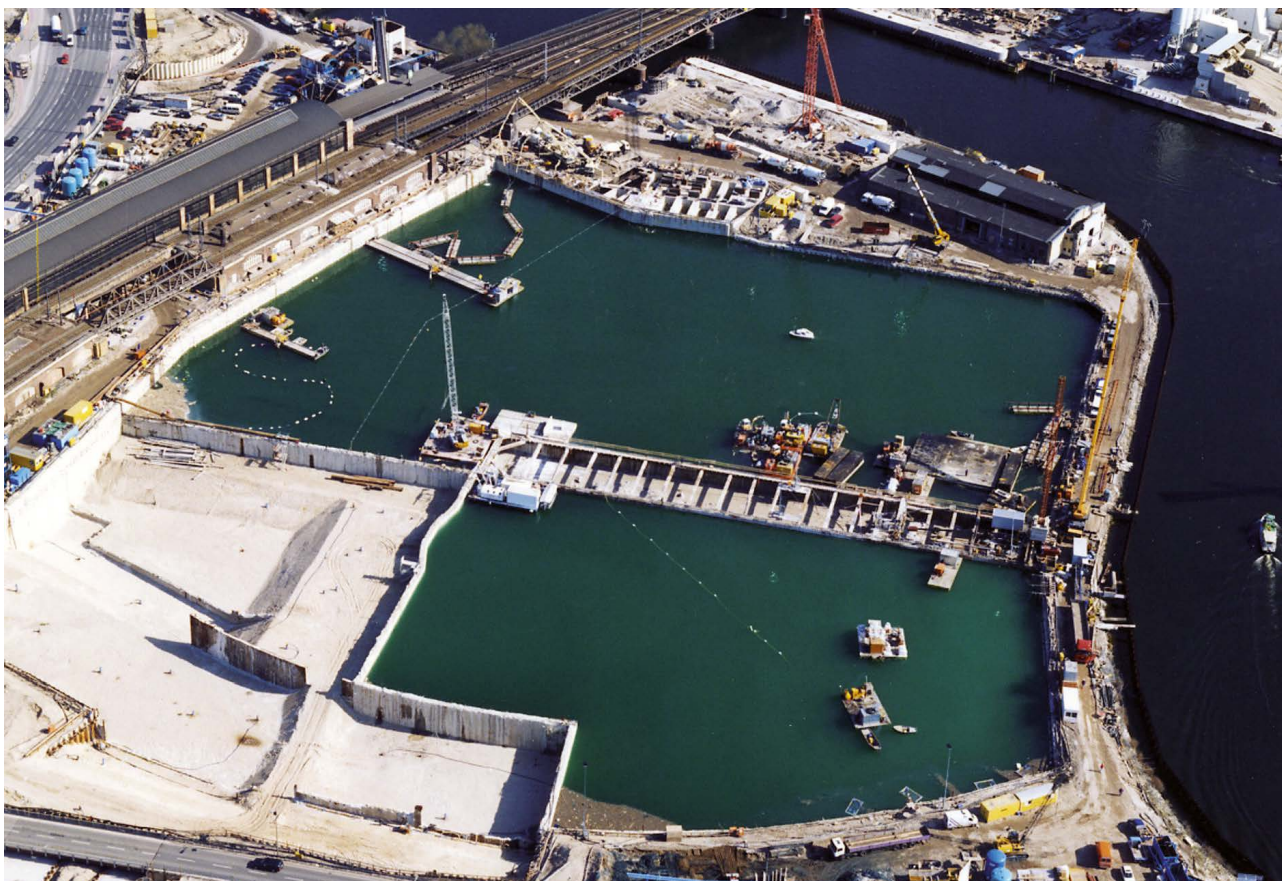
4. ábra: \text{CO}_2 -vel történő semlegesítés a berlini főpályaudvar építésénél.
