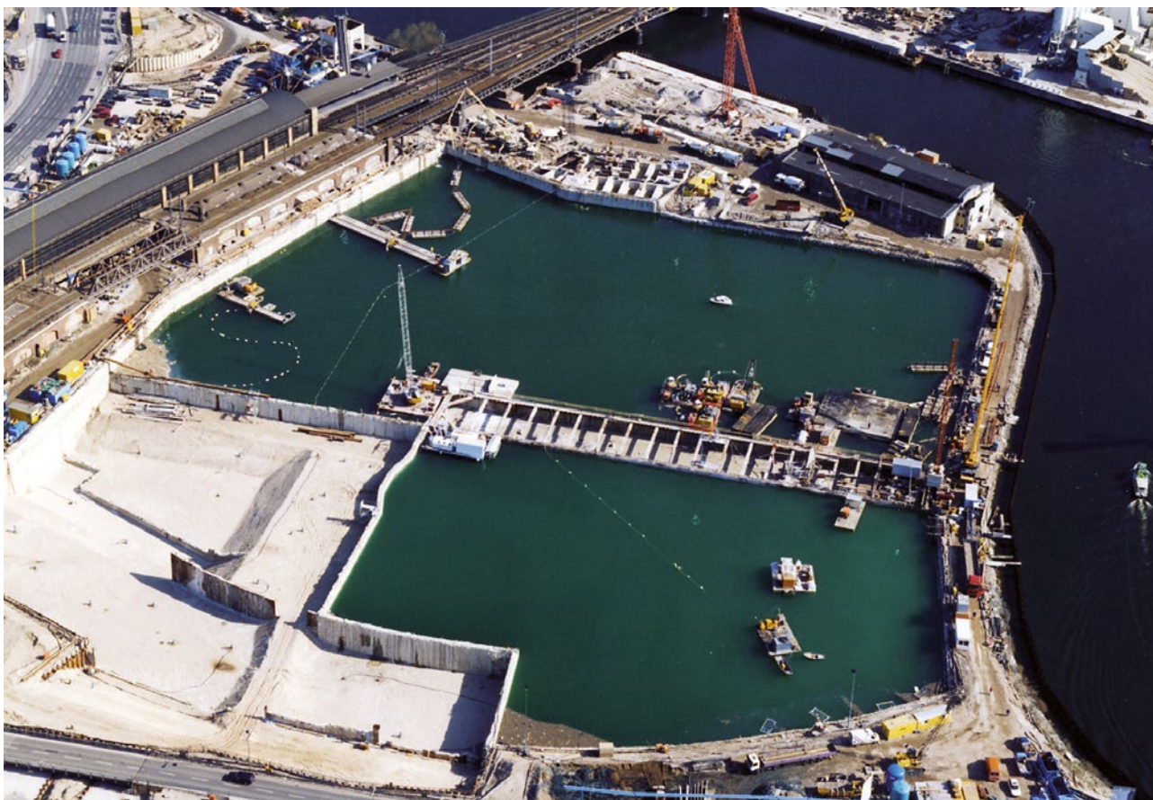
4. ábra: \text{CO}_2 -vel történő semlegesítés a berlini főpályaudvar építésénél.
