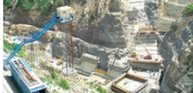
Nagy mennyiségű frissbeton hűtése. (Bulgária)
