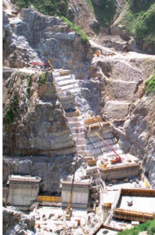
Nagy tömegű beton bedolgozása Bulgáriában.
