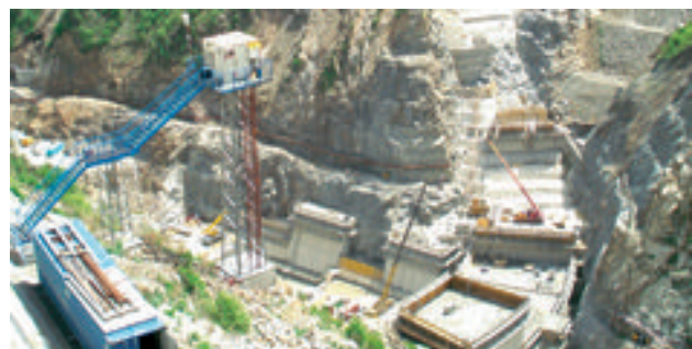
Nagy mennyiségű frissbeton hűtése. (Bulgária)
