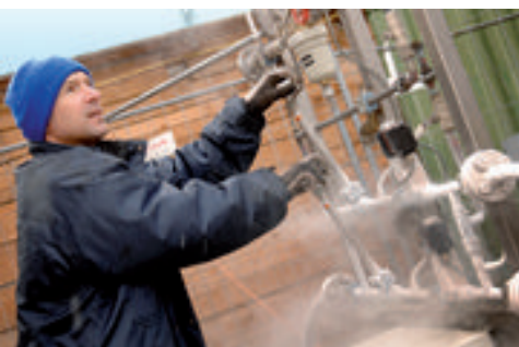
A cementhűtő berendezés beállítása.
