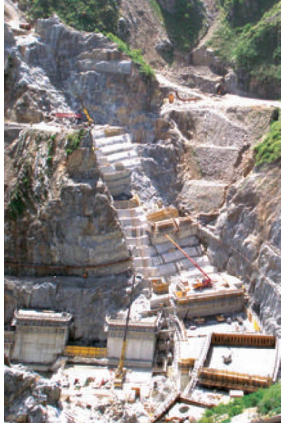
Nagy tömegű beton bedolgozása Bulgáriában.
