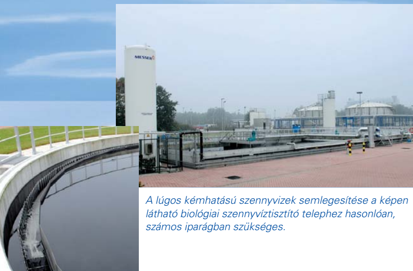
A cseppfolyós szén-dioxiddal történő semlegesítés kis alapterületen is kivitelezhető.
