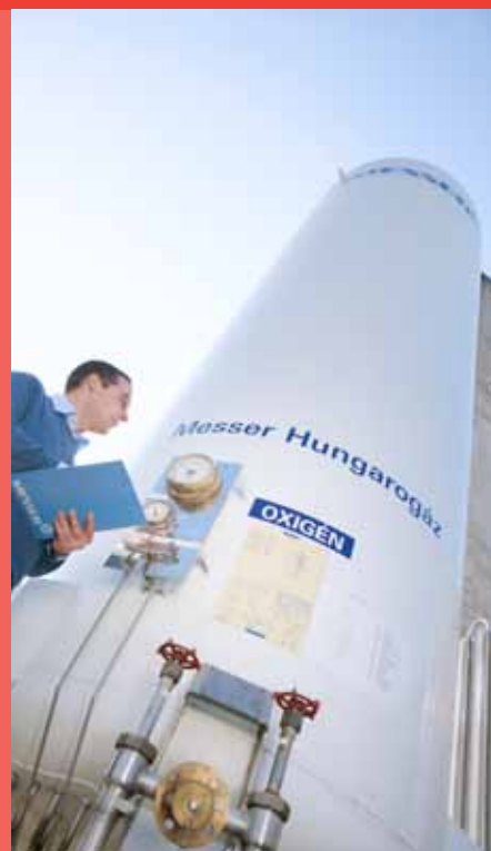
A cseppfolyós oxigént közvetlenül a partner telephelyén tároljuk tartályokban.
